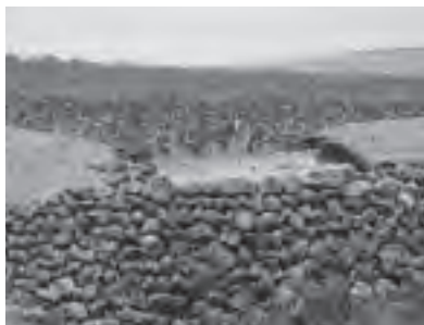
Detalle de una boca de gavia en Teseguite.
