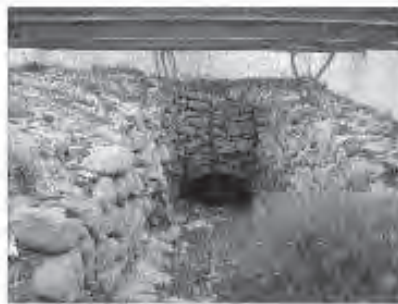
Entrada de acceso al pozo y brocal tapiado con rejería de hierro.
