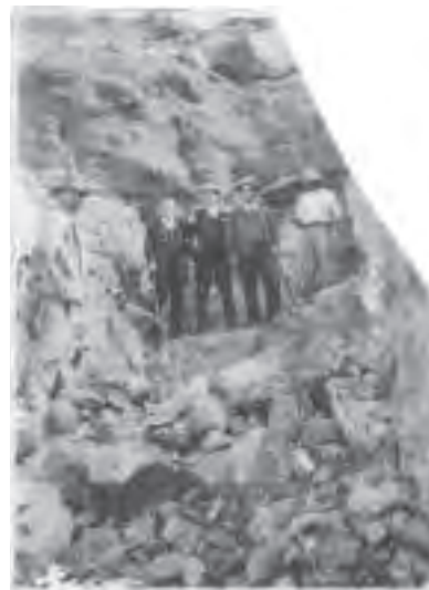
Ingenieros y trabajadores de las galerías de Famara.
