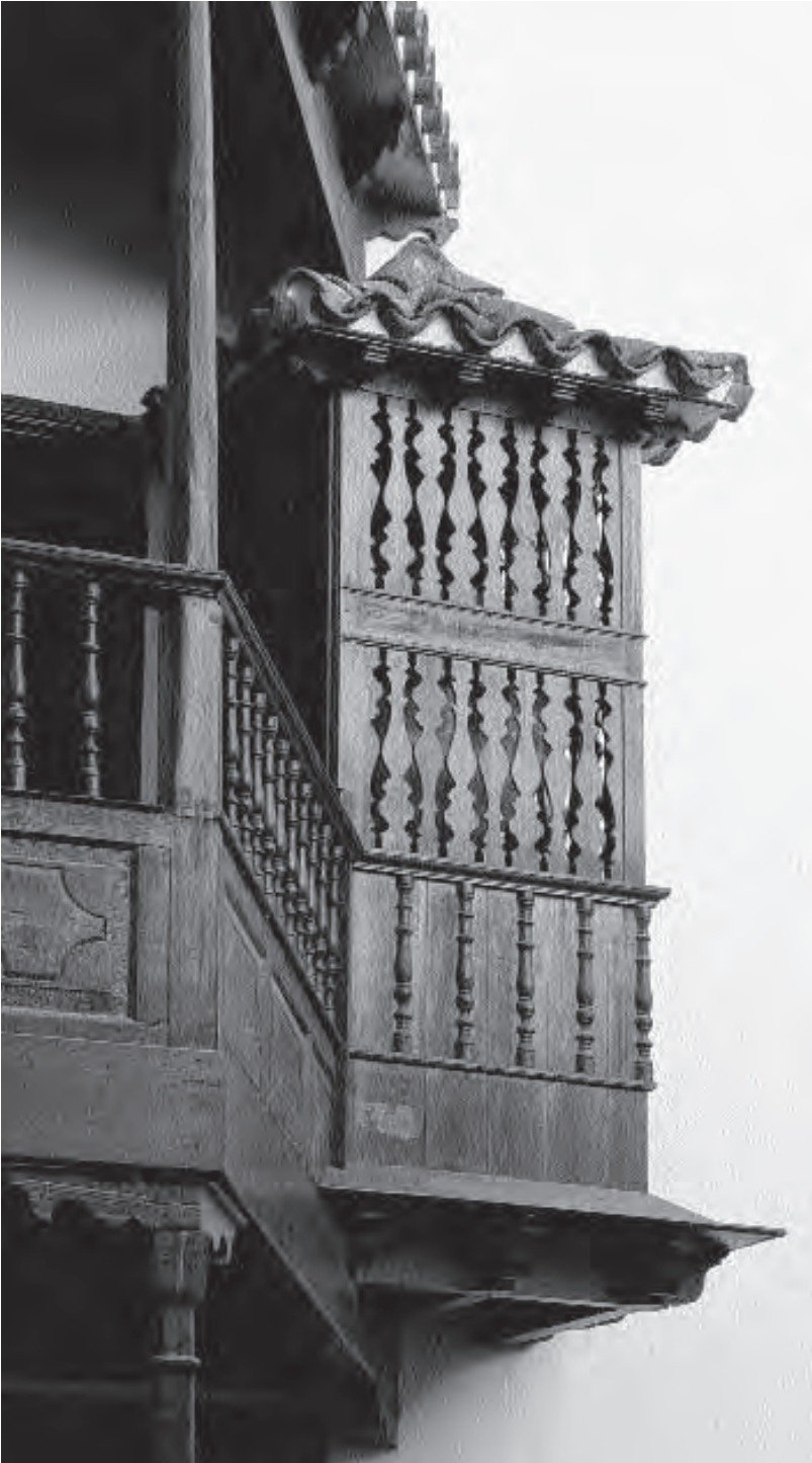
El corredor del patio de la Casa Arroyo de Arrecife reserva un espacio para la instalación de la destiladera.
