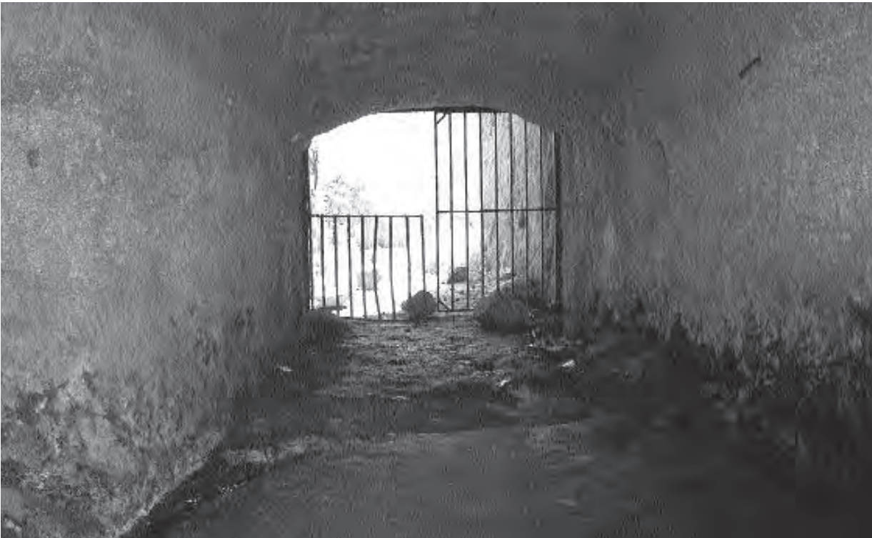
Túnel de entrada a Chafariz.
